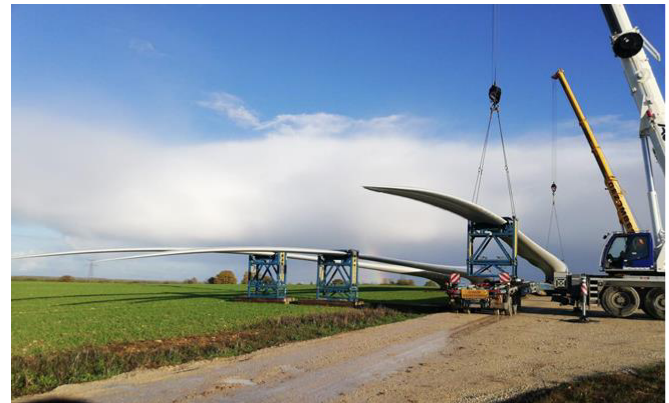
Figure 55 : Stockage des pâles durant le chantier
